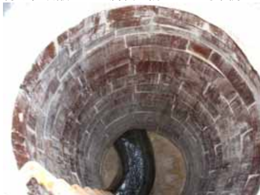
写真 2 泥焼成タイル貼付後のマンホール
