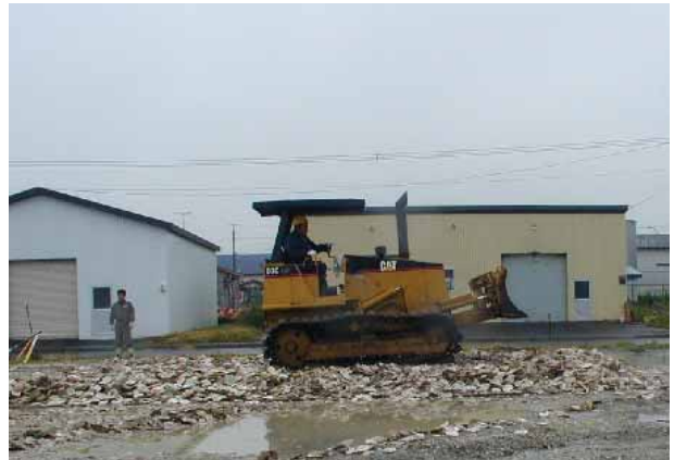
写真-1 重機によるホタテ貝殻の破碎
