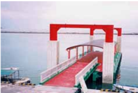
写真-6 屋根付浮体式係船岸の例
