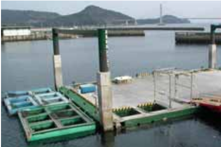
写真-5 生簀と簡易クレーンの設置例
