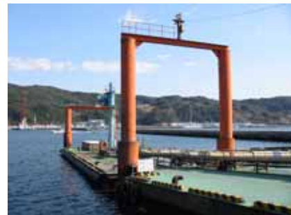
写真-4 荷役装置の設置例
