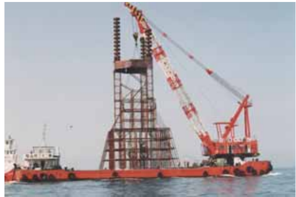
写真-1 設置海域まで回航中の高層魚礁
