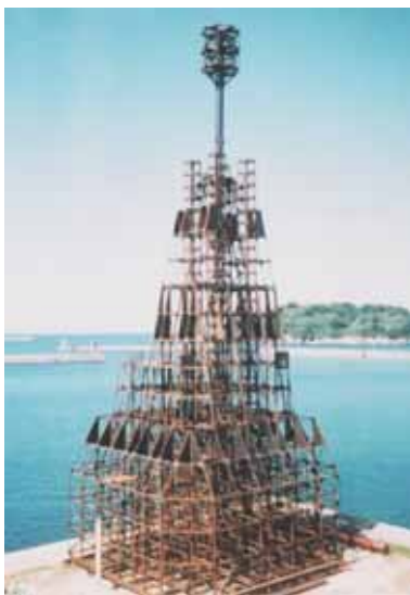
写真-3 組立完了時の振子式高層魚礁
