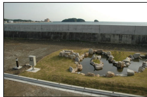
写真-2 修景施設を兼ねた放流水路
