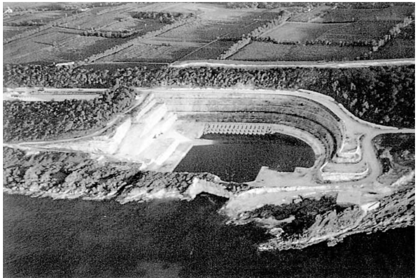
図 - 1 漁港建設状況
