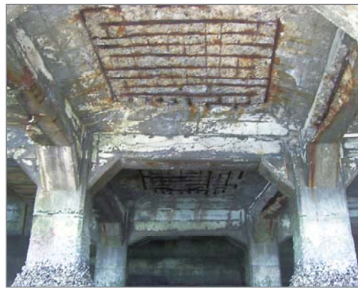
コンクリートの剥離・脱落と鉄筋の腐食
