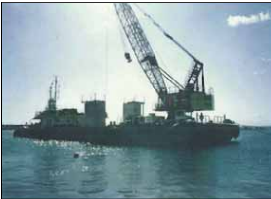
写真3 プレキャストコンクリートブロック 海上運搬状況
