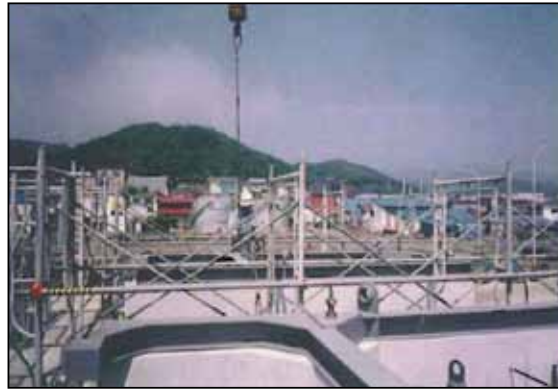
写真2 吊り台取付状況
