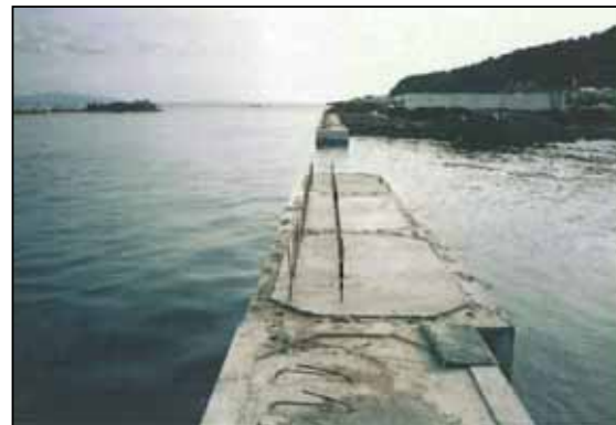
写真6 施工完了状況
