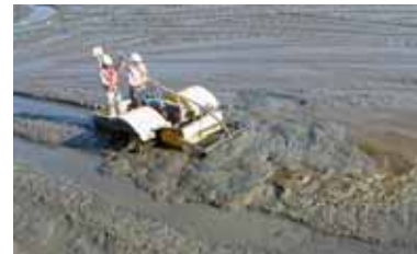
写真-2 干潟走行機稼働状況
