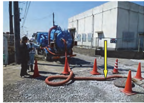
写真-7 マンホールからの汚水引抜作業
