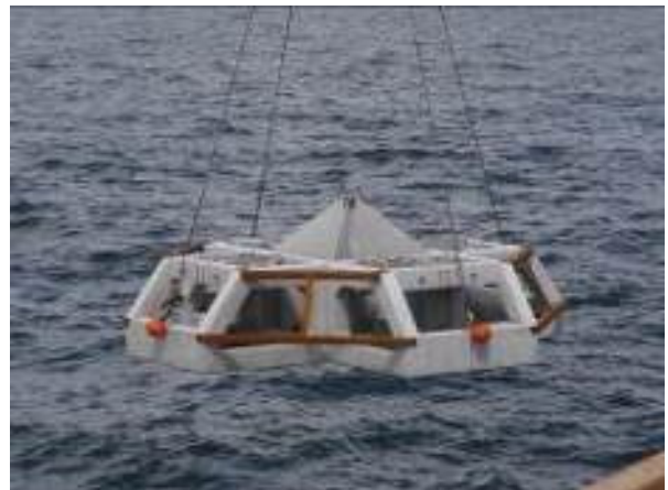
図-2 流動制御機能を有する人工魚礁
