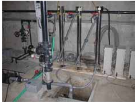
図-9 紫外線照射装置（現地設置型）
