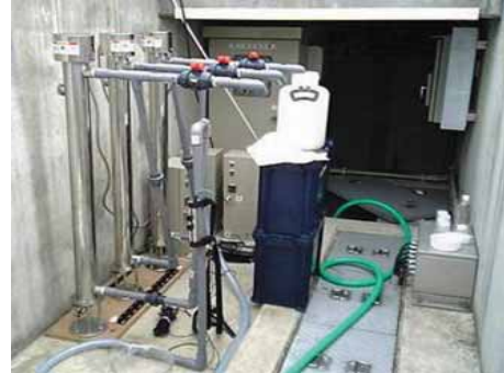
図-5 紫外線照射装置 (現地設置型)
