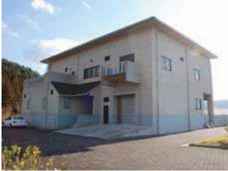
図-4 A地区漁業集落排水施設
