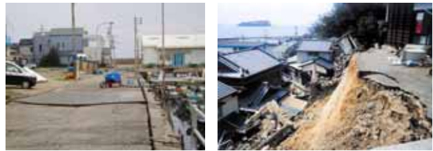
写真-4 被災した岸壁と集落（玄界島）
