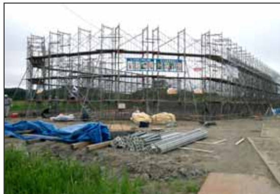
図-9 建設中の污水处理施設(水槽部)
