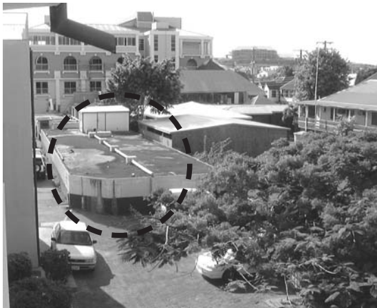
図 - 7 パッケージプラントの外観
