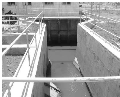
図 - 5 グリーンベイ地区排水機場
