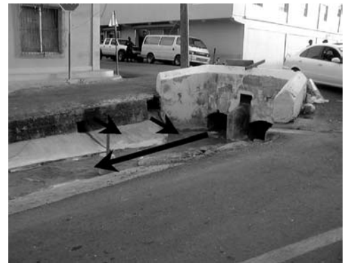
図 - 11 タンナー通りの排水路
