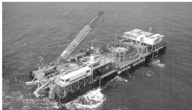
図 - 4 取水管敷設専用台船
