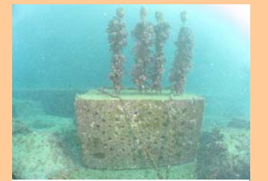
巣穴を開けたブロックを設置
