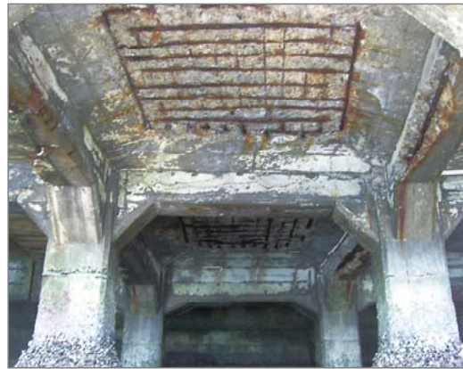
コンクリートの剥離・脱落と鉄筋の腐食
