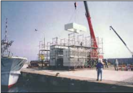
写真1 プレキャストコンクリートブロック 組立状況
