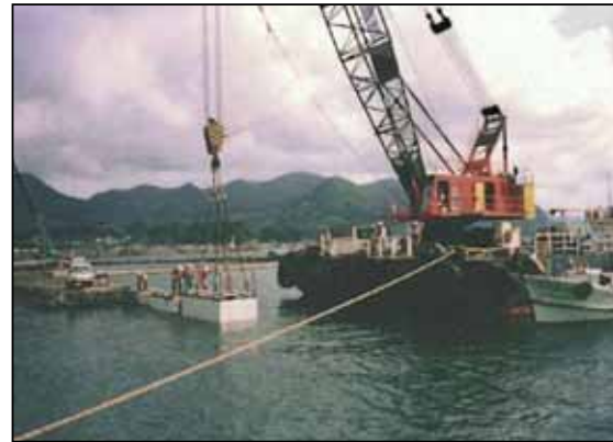
写真4 プレキャストコンクリートブロック 据付状況
