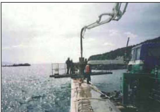
写真5 水中コンクリート打設状況
