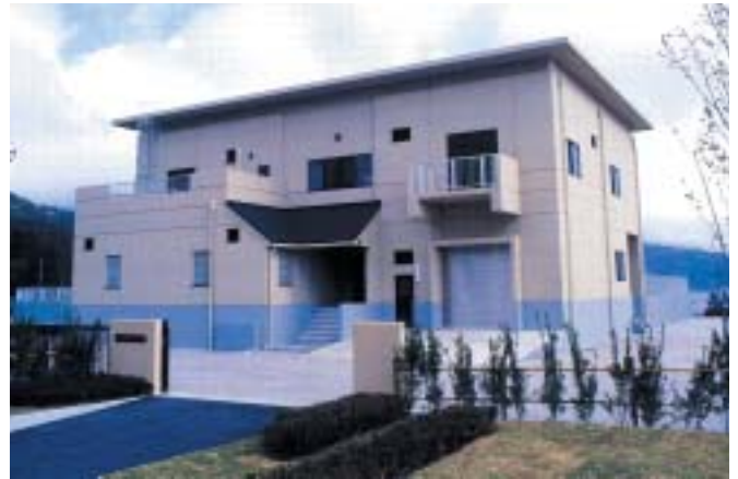
平成12年6月に供用開始された集落排水処理施設
