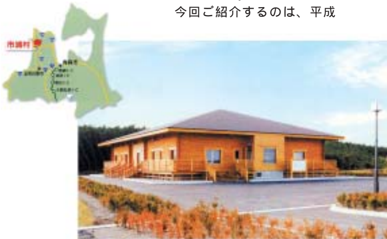
十三地区浄化センター「水の館」
