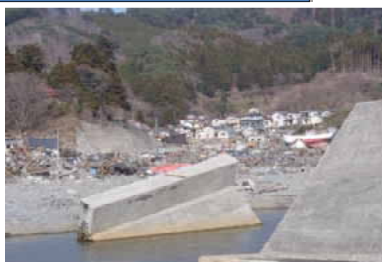
倒壊した防潮堤と低地集落の壊滅(大槌漁港)
