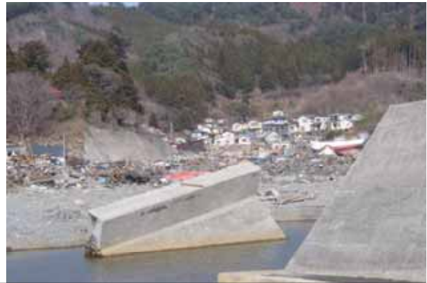
倒壊した防潮堤と低地集落の壊滅(大槌漁港)
