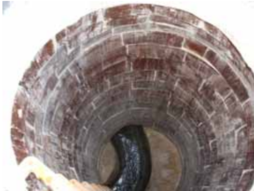
写真 2 泥焼成タイル貼付後のマンホール
