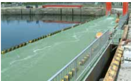
写真-7 転落防止用手すりの設置例
