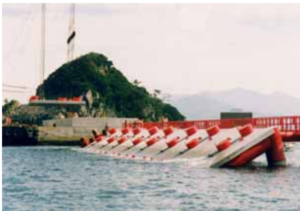
図-2 長崎県南風泊漁港のジャケット式防波堤
