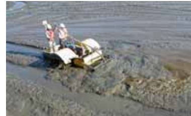
写真-2 干潟走行機稼働状況
